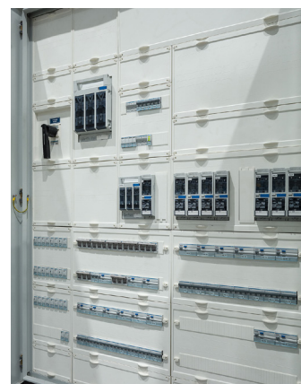
Hala logistyczna, Łódź
