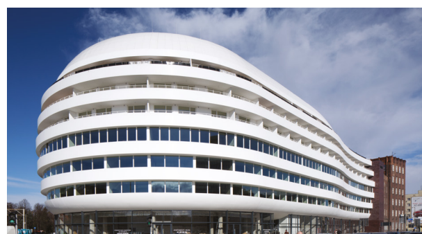
Ovo Wrocław Apartments Zastosowano w apartamentach oraz części hotelowej: rozdzielnice unimes H, volta, aparatura modułowa.
