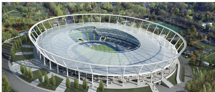
Stadion Śląski, Chorzów Rozdzielnica główna na prąd znamionowy 2500 A.
