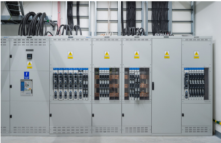
Hala logistyczna, Sosnowiec
