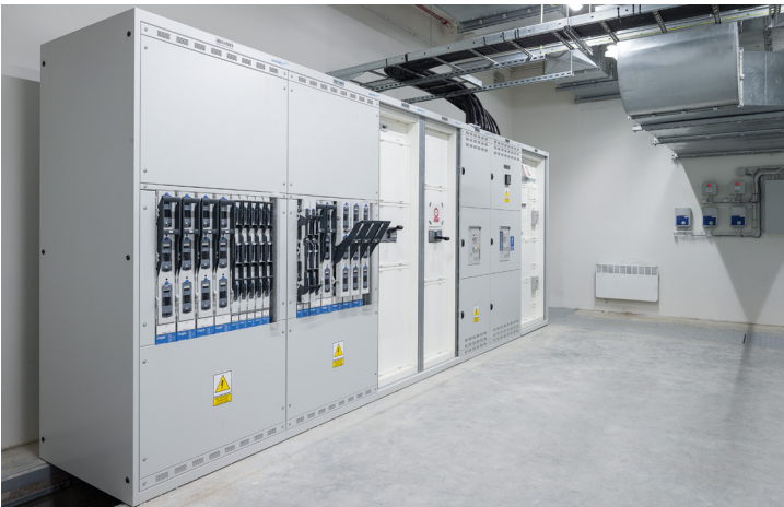
Hala logistyczna, Kołbaskowo
