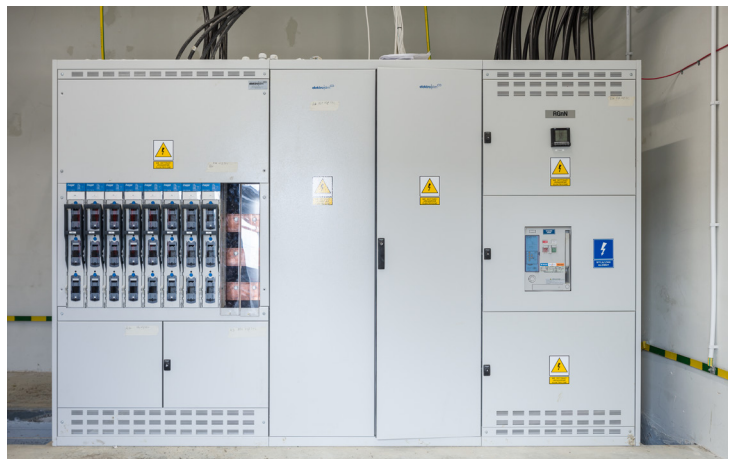
Hala logistyczna, Bielany Wrocławskie
