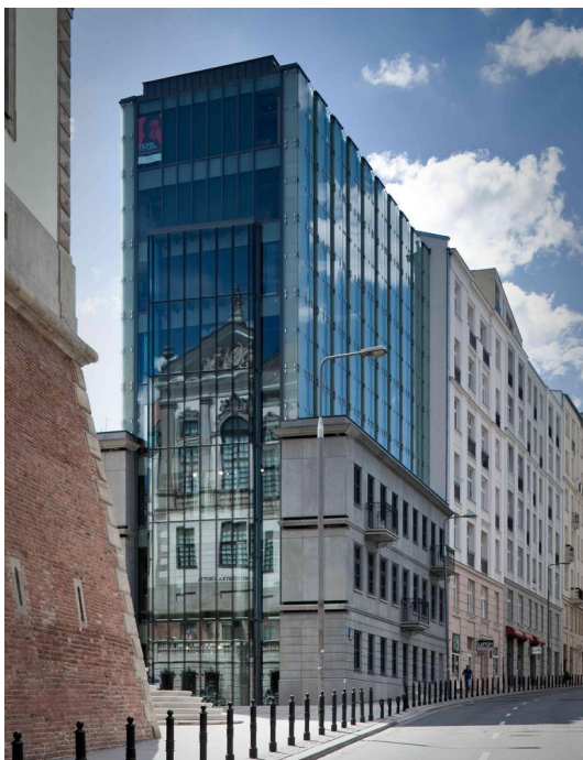
Centrum Chopinowskie, Warszawa Rozdzielnica główna z zaawansowanym układem automatyki SZR.
